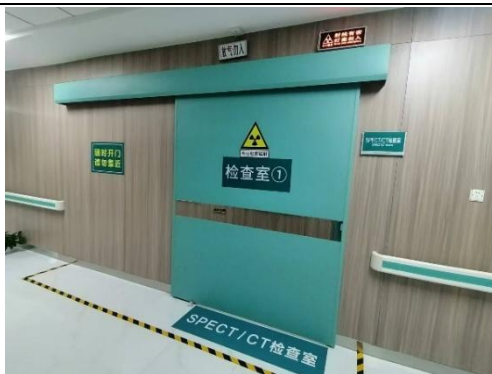
SPECT/CT 室设置门灯连锁、警告标识，电动推拉门带有防夹功能
