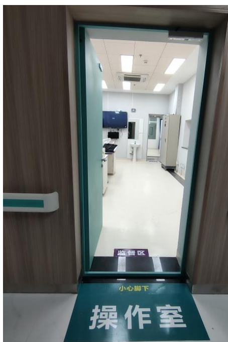
SPECT/CT 室设置门灯连锁、警告标识，电动推拉门带有防夹功能
