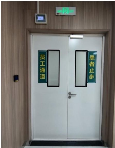
员工通道入口处设置标识、区域环境辐射检测仪、门禁
